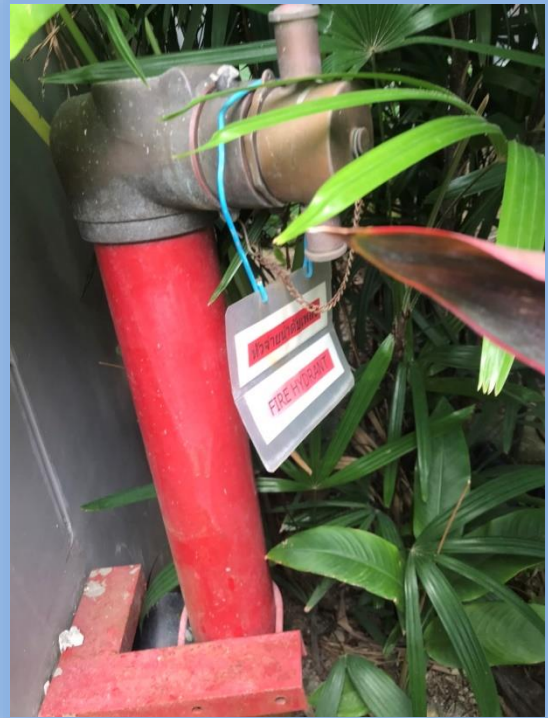
ภาพที่ 1-18 หัวรับน้ำดับเพลิงและระบบท่ออื่น
