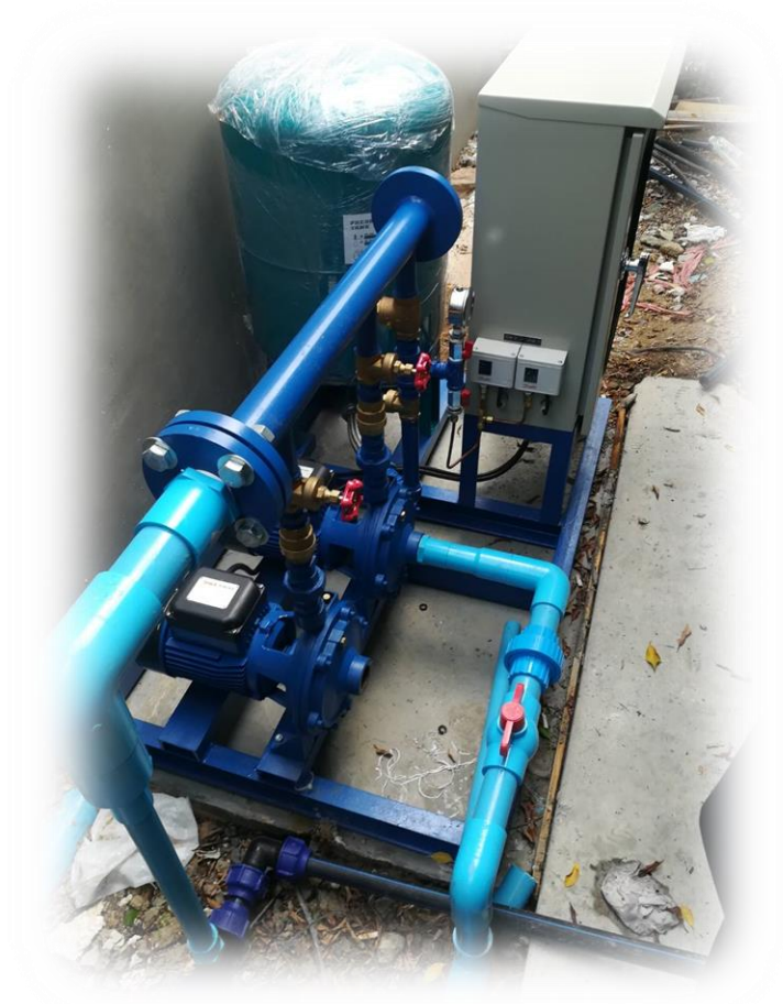
ภาพที่ 1- 7 การนำน้ำทิ้งมาหมุนเวียนใช้ในการรดน้ำต้นไม้ภายในพื้นที่โครงการฯ
